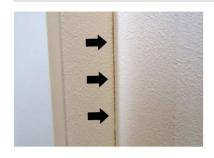
コーナー部分やクロスと 枠の境界に塗ってあるコーキングが切れて、隙間 が発生しているように見 えます。
